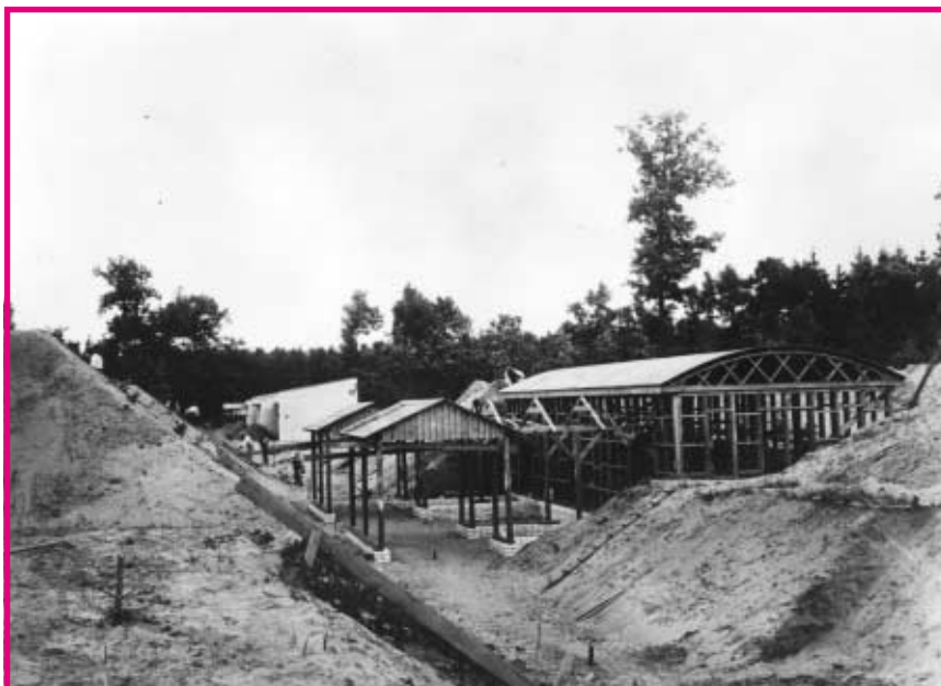
výstavba objektu L 13, kde se vyráběl černý prach (1921)
