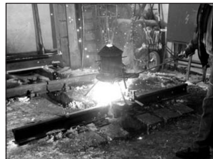
jedna z praktických ukázek svařování kolejnic
