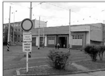
pohled zvenčí na depo tramvaj v Hostivaři
