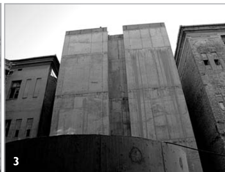
obr. 1 – vnitřní dvůr objektu, železobetonová konstrukce přístavby – únor 2012 obr. 2 – práce na opravách štukové výzdoby – únor 2012 obr. 3 – vnitřní dvůr objektu, dokončena železobetonová konstrukce přístavby – březen 2012 obr. 4 – detail konstrukce ocelobetonového stropu – březen 2012 obr. 5 – objekt z ulice Štefánikova – dodávka replik původních oken, v pozadí probíhají práce na fasádě – začátek dubna 2012
