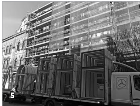
obr. 1 – vnitřní dvůr objektu, železobetonová konstrukce přístavby – únor 2012 obr. 2 – práce na opravách štukové výzdoby – únor 2012 obr. 3 – vnitřní dvůr objektu, dokončena železobetonová konstrukce přístavby – březen 2012 obr. 4 – detail konstrukce ocelobetonového stropu – březen 2012 obr. 5 – objekt z ulice Štefánikova – dodávka replik původních oken, v pozadí probíhají práce na fasádě – začátek dubna 2012
